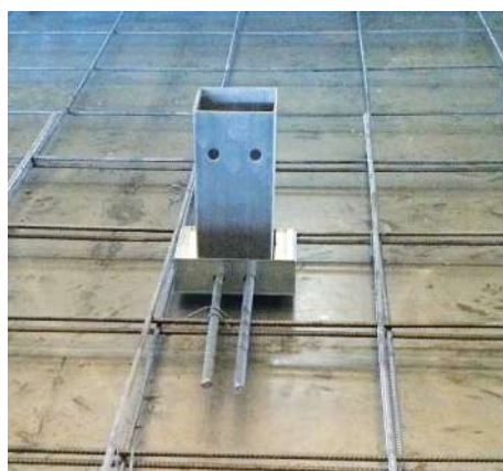
Fondo cassero Formwork
