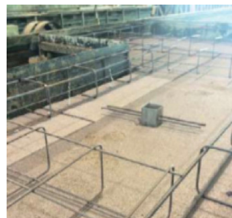
Isolante posato Isolation posée
