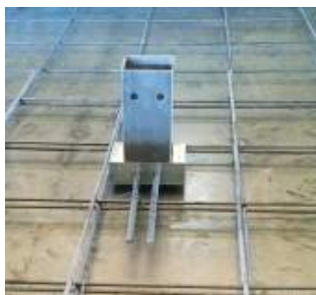
Fondo cassero Formwork
