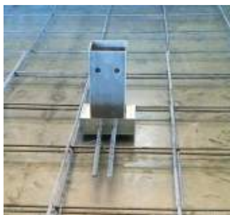
Fondo cassero Formwork
