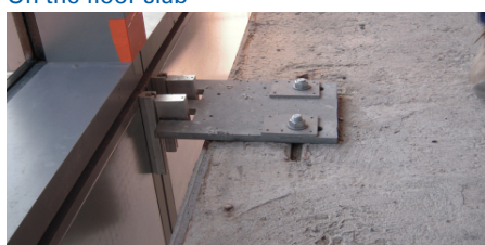
Ancoraggi delle facciate del grattacielo Diamante a Milano area Porta Nuova - Garibaldi Skyscraper Diamond facade anchoring in Milan area Porta Nuova - Garibaldi
