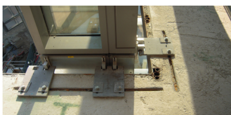
Ancoraggi delle facciate del grattacielo Diamante a Milano area Porta Nuova - Garibaldi Skyscraper Diamond facade anchoring in Milan area Porta Nuova - Garibaldi
