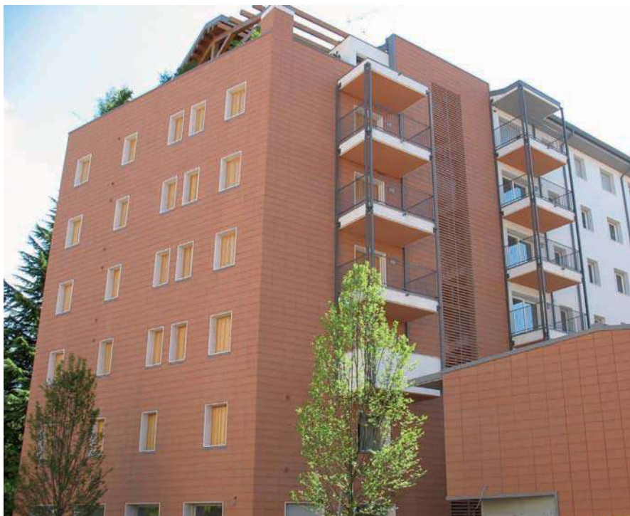
FACCIATA VENTILATA IN TAVELLE IN COTTO. EDIFICIO RESIDENZIALE A PORDENONE. STUDIO DI ARCHITETTURA RAFFIN E STUDIO DI ARCHITETTURA E URBANISTICA FRANCESCO GIARNELLI.
