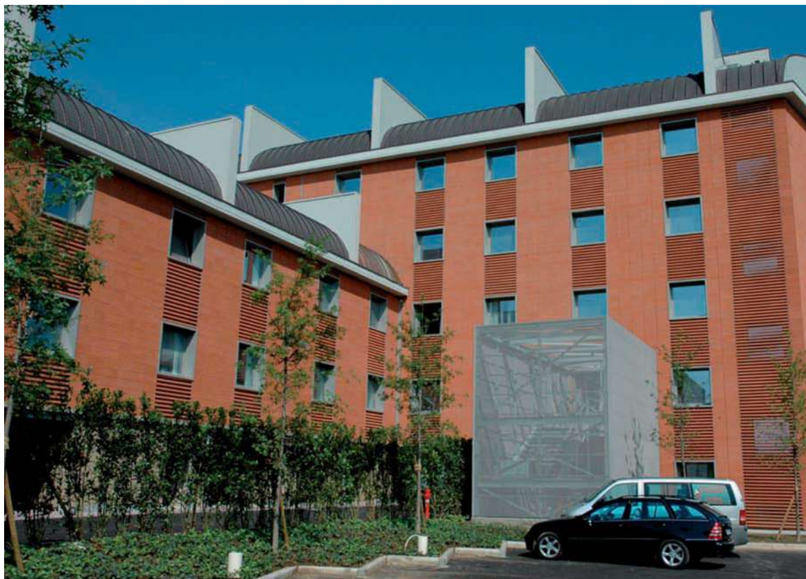
HOTEL CRUISE, COMO. FACCIATA E FRANGISOLE IN COTTO. ARCHI- TETTO ANTONIO PILI. HOTEL CRUISE, COMO. TERRA- COTTA FACADE AND SUNBREAKER. ARCHITECT: ANTONIO PILI.
