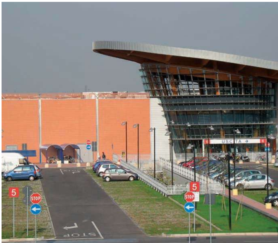
CARREFOUR A LAMBRATE (MI). FACCIATA VENTILATA IN COTTO. STUDIO DI ARCHITETTURE AEDIS.
